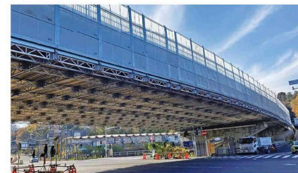
館高架橋（東京都）
